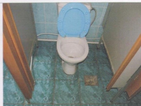
Фото №27 – Санитарно-гигиеническое помещение (туалетная кабина в общей уборной)
