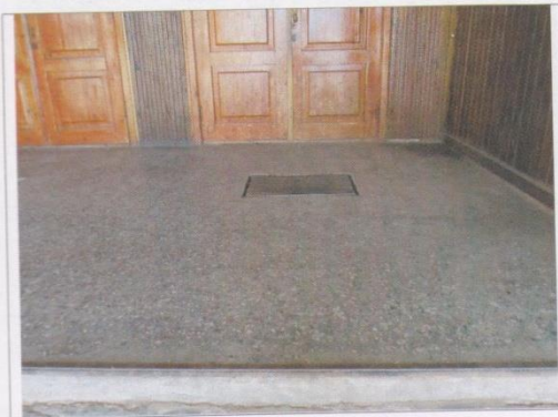
Фото №5 – Входная площадка главного входа
