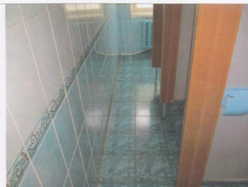
Фото №28 - Санитарно-гигиеническое помещение (туалетная кабина)
